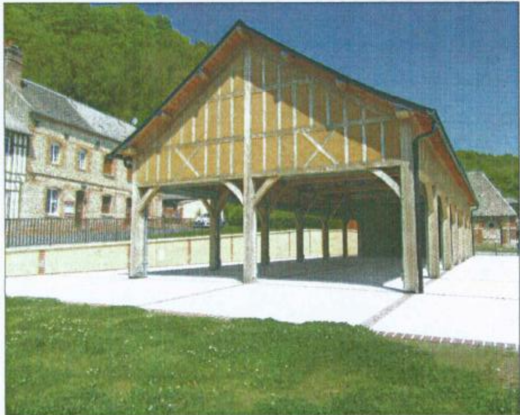
Les halles de Grainville-la-Teinturière
